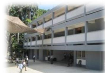
L'École Primaire remise en état pour la rentrée 2011
