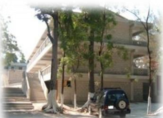
Le Bâtiment du Secondaire AVANT le séisme
